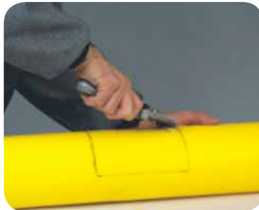
Oksitli tabakanın traşlanması/ Scraping the oxidated layer
