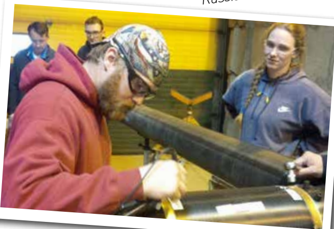
USA Sleeve - Manşon Uygulaması USA Sleeve - Coupler Installation
