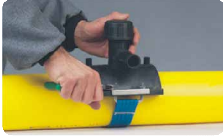
Te-branşmanın kaynak öncesi boru üstünde sıkılması/ Tightening of Tee-branch on the pipe
