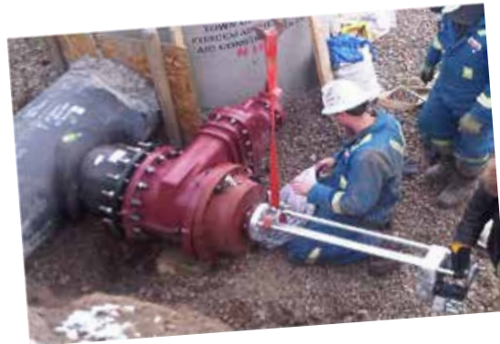
Kanada - 28"x18" IPS EF Semer Canlı Hat Bağlantısı Canada - 28"x18" IPS EF Saddle Hot Tapping Application
